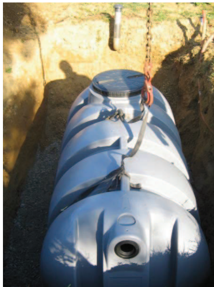
Pose d'une fosse toutes eaux SEBICO FAN au CSTB
